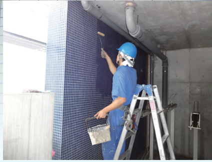
タイル面へのローラーによる施工
