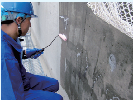
築14年のコンクリート打ち放し建築物への塗布。Sクリートガードの高い浸透性能がよく分かります。
