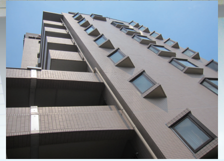
施工後の様子。外観の変化はありません。(※1)
