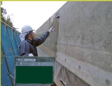
S クリートアップの塗布
