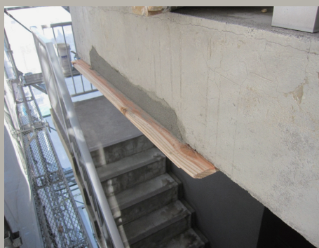
補修モルタルで再成形。
