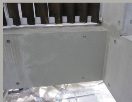
コンクリートの補修(改質)のため、Sクリートアップを塗布後、Sクリートクラック(超微粒子セメント)にて、表面被覆補修をする。Sクリートアップの効果にて、強靱な接着性が保たれる。
