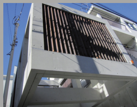
施工終了。美観がよみがえり、長期に美観を維持し、コンクリートを保護します。
