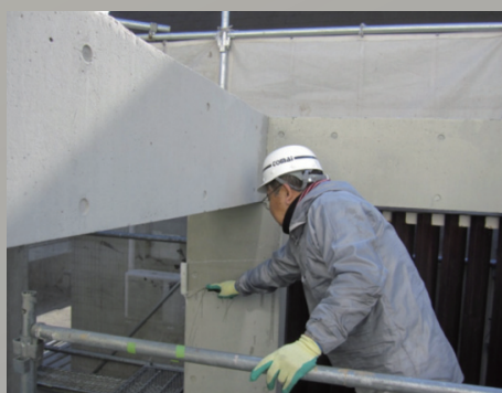
Sクリートガードを塗布。 SクリートガードとSクリートカラーは同じシロキサン系のため塗材の相性が良く、Sクリートガードの撥水力が保持される。
